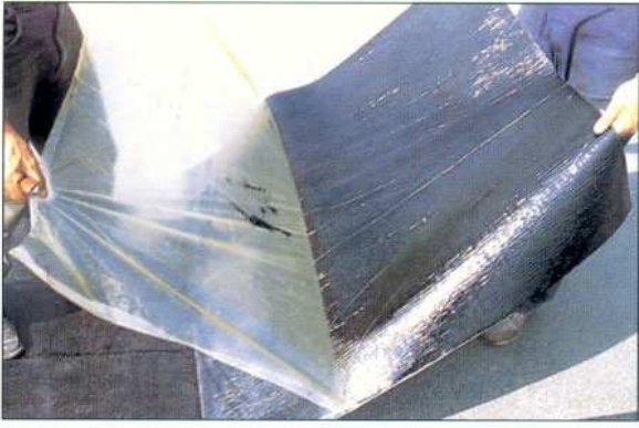
Kendinden yapışkanlı membran uygulaması sırasında, yapışkan koruyucu tabakanın ayrılması.
