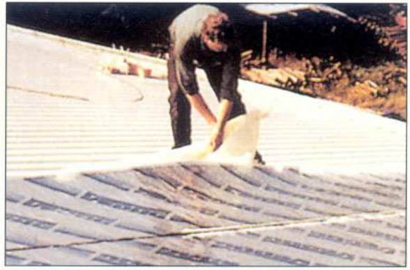
Metal trapez çatı üzerine, kendinden yapışkanlı buhar kesici Vedagard SK'nın kolaylıkla uygulanması.
