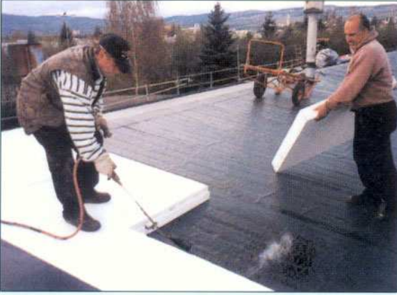
Vedagard SK Plus'in özel üst tabakasının üzerine (herhangi bir yapıştırma işlemi ya da mekanik tespit yapmadan), ısıtma yöntemi ile EPS uygulaması.
