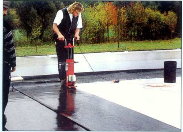
Beton zeminde, ısı yalıtımı tabakaları üzerine, su yalıtım membranı Vedaplan MF'in uygulanması.
